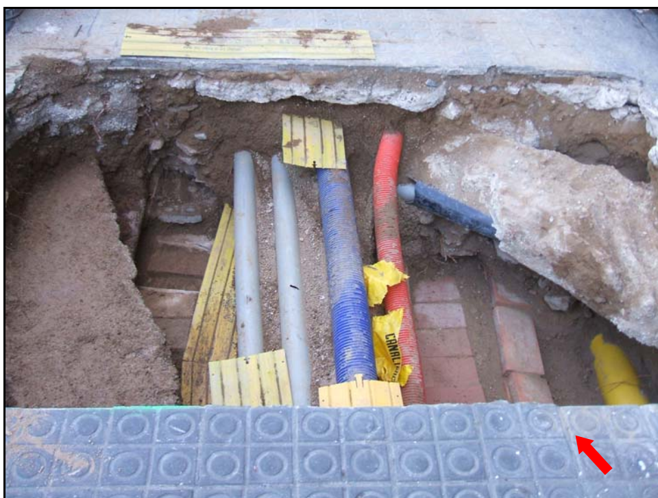
Fotografia 7: Serveis a l'extrem SW del Sondeig 2
