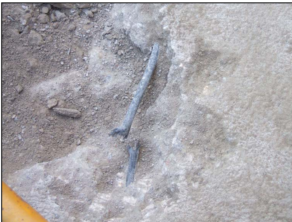
Fotografia 25: Cable de l'enllumenat públic trencat
