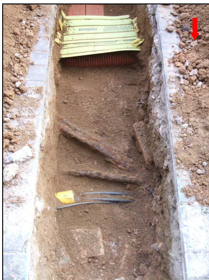
Fotografia 28: Rasa de serveis, al carrer Pelai, 40 (Sondeig 10)
