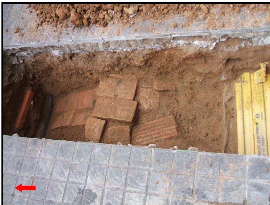
Fotografia 27: Rasa de serveis, al carrer Pelai, 42 (Sondeig 9)
