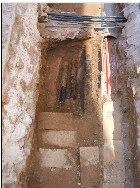
Fotografia 14: Detall dels serveis una vegada extrets part dels maons
