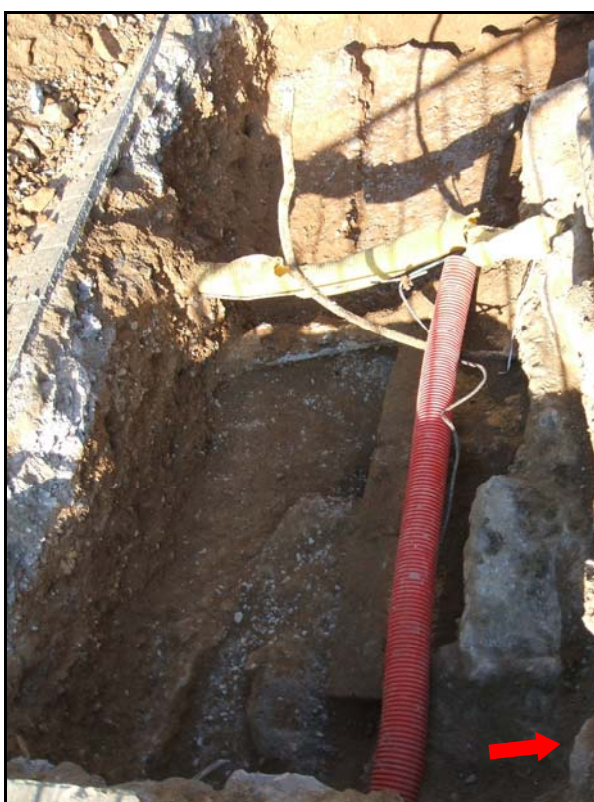
Fotografia 16: Meitat est del Sondeig 6, amb formigó i cablejat
