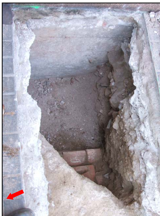
Fotografia 12: Cala de serveis al costat del Sondeig 4
