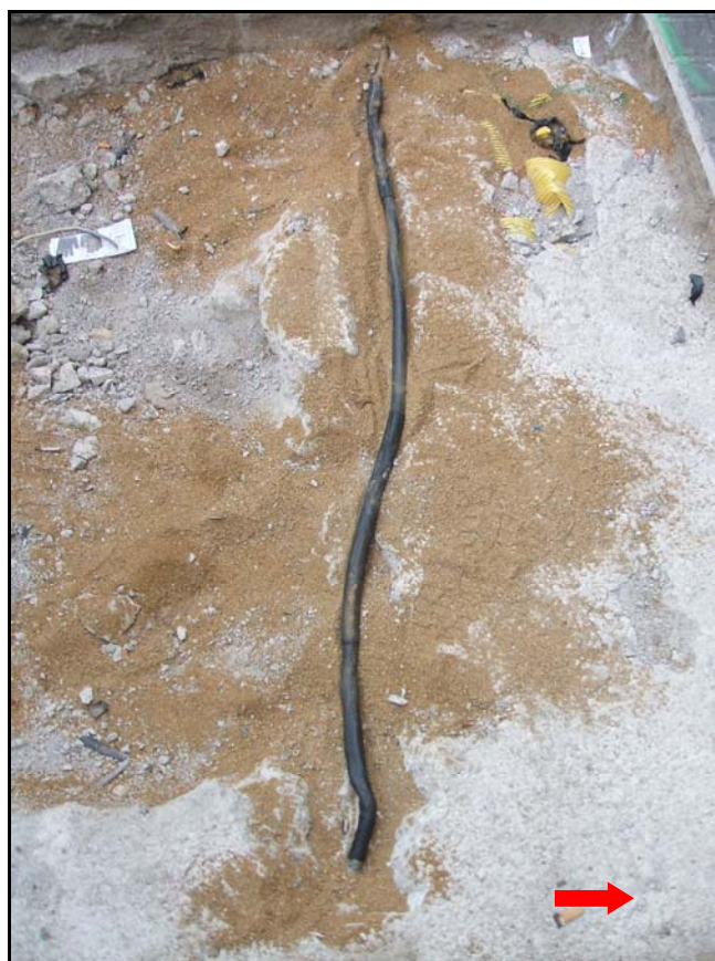
Fotografia 26: Cable trencat degudament reparat
