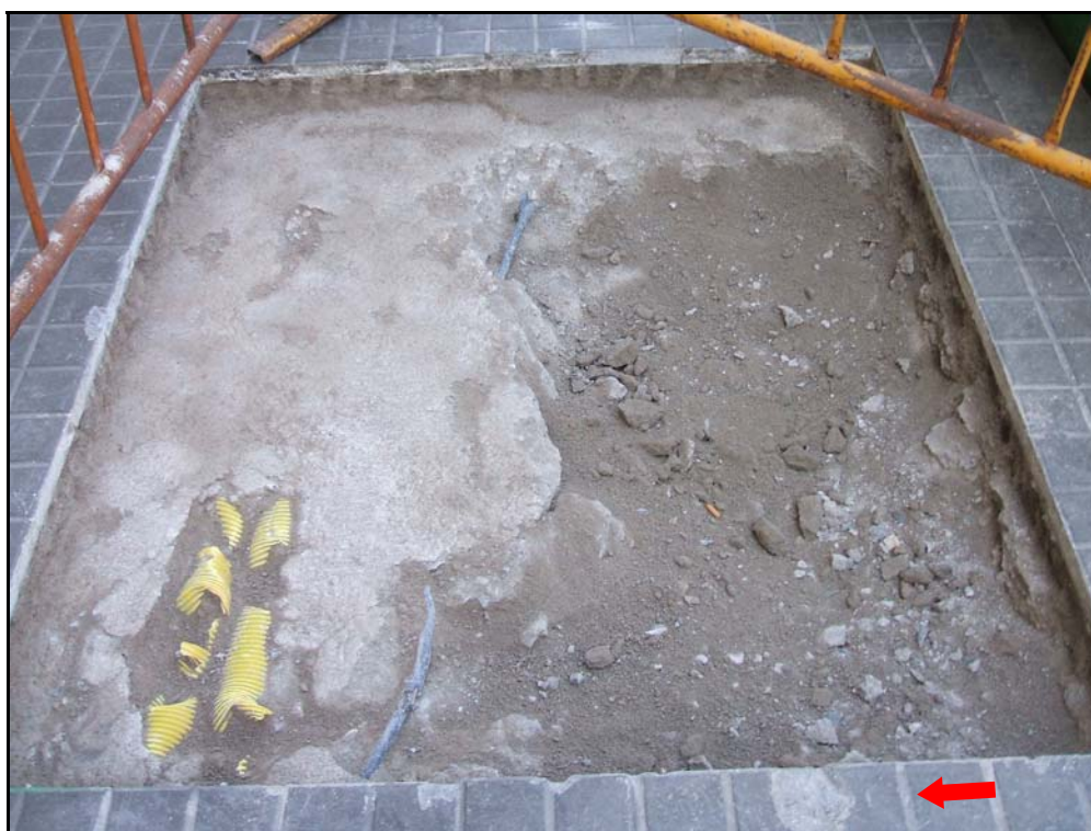
Fotografia 24: Sondeig 9, amb els serveis elèctrics
