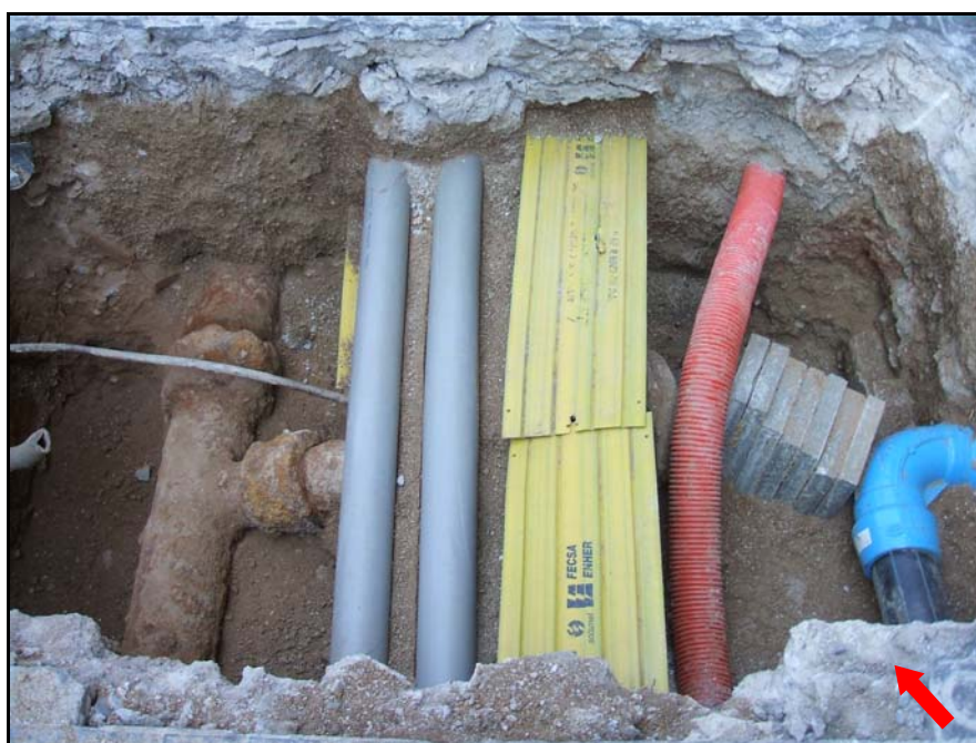
Fotografia 6: Serveis a l'extrem NE del Sondeig 2
